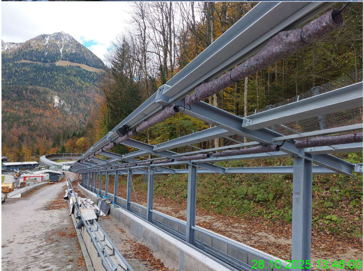
ANLAGE 03: Elektromontage an Stahlbaukonstruktion Bahn-Überdachung
